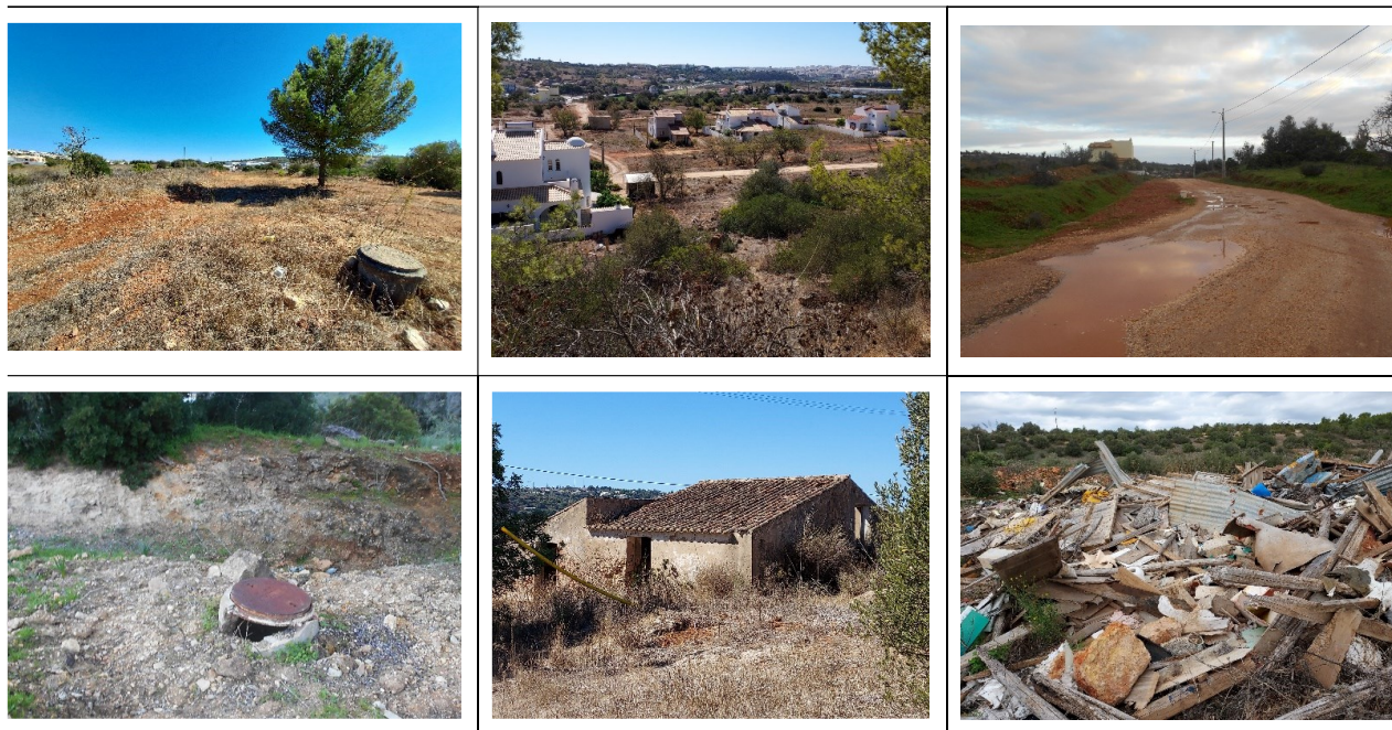
Figura 2. Aspetos do terreno onde se localiza o Loteamento
